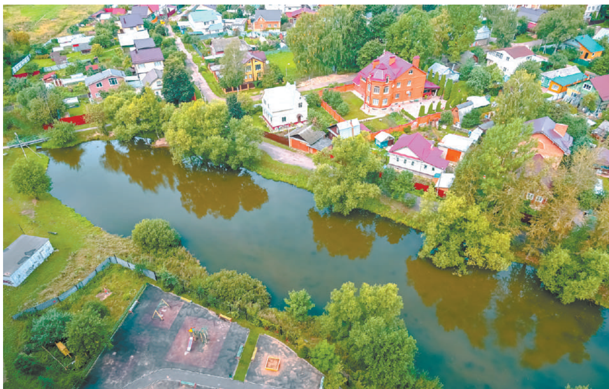
Конкурс по определению подрядчика, который будет благоустраивать территорию «Северных прудов», уже состоялся. Проект будет готов к сентябрю следующего года.
